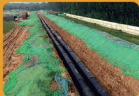
邯郸中电洲际东部城区集中供热项目 (口径:DN1200,设计温度120/60℃,设计压力1.6Mpa)
