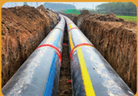
西安大唐户县电厂至三星热源厂长输供热项目 (口径:DN1200,设计温度130/70℃,设计压力1.6Mpa)
